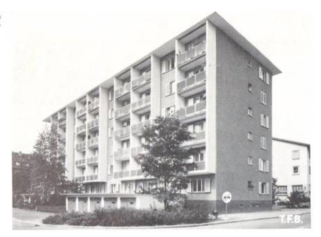
Abb. 1 Wohnhaus in Dietikon ZH, vollständig erstellt aus Betonelementen, die auf der Baustelle vorfabriziert worden sind (Projekt und Ausführung: D. Lanfranconi, Zürich).
