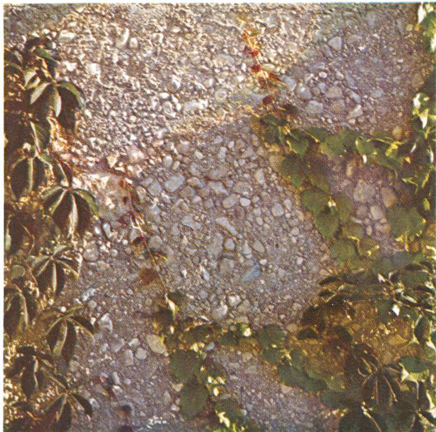
von 150 bis 200 mm. Die Zementdosierung war dementsprechend auf 200 kg/m<sup>3</sup> angesetzt. Dies entspricht ungefähr einer Mischung P 300 mit gewöhnlichem Zuschlagsmaterial.
