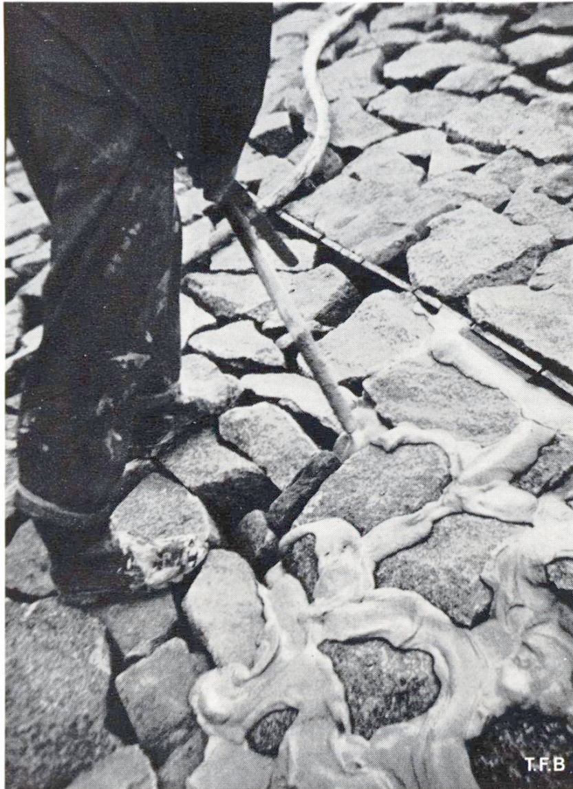
Abb. 2 Herstellen von Colcrete- Ausgussbeton, Damm geschüttet, Oberfläche gesetzt, 20–30 cm tief vermörtelt. Böschungsneigung 1:1½ bis 1:2½.
