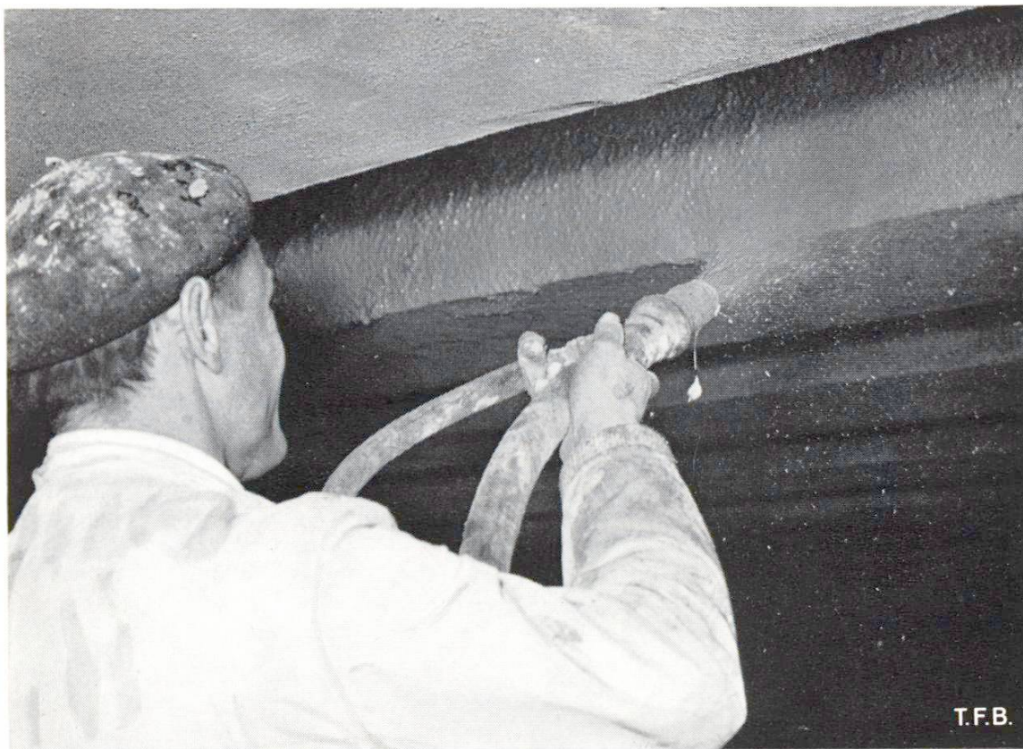
Abb. 4 Gespritzter Colgrout. Lagenweises Aufspritzen von Colcrete-Beton mit der Colcrete-Spritzdüse bis zum vollen Querschnitt der Plattenbalken einer Tunneldecke.
