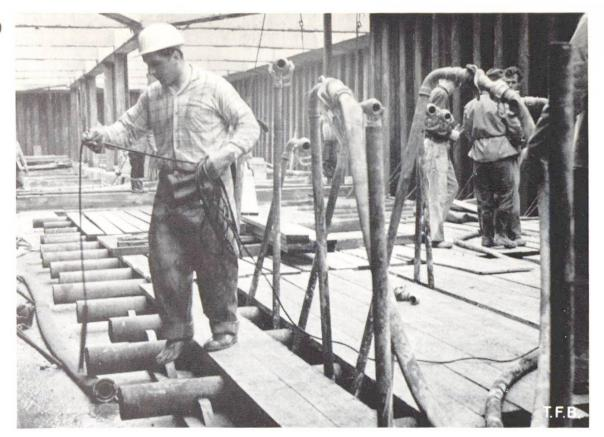
Abb. 3 Herstellen von Colcrete-Massenbeton unter Wasser für eine Schleusensohle.
