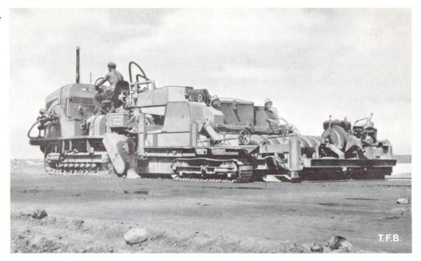
Abb. 3 Maschinenzug, der das Bodenmaterial auflockert, mit Zement und Wasser mischt und verdichtet (Eingangmischer). Die Operation kann auch durch hintereinander gereihte Einzelmaschinen durchgeführt werden (Mehrgangmischer).
