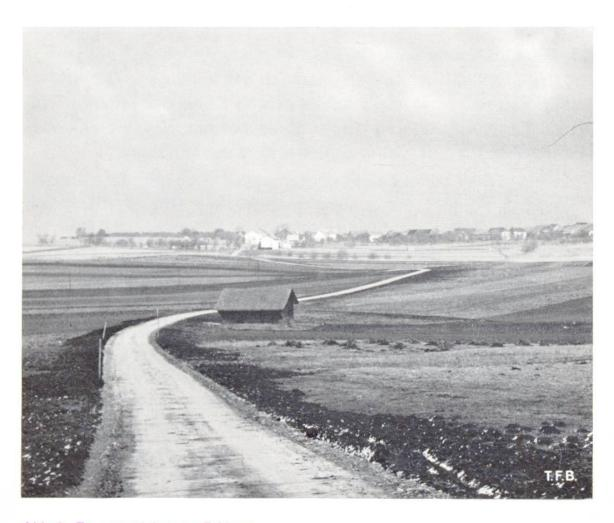
Abb. 6 Zementstabilisierter Feldweg.
