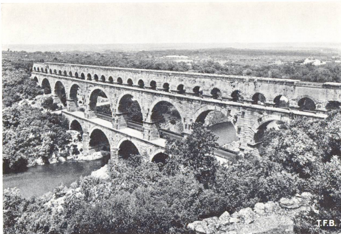
Abb. 3 Den noch an Natursteine gebundenen Baumeistern gelang schon früh die Überbrückung verhältnismässig grosser Spannweiten mit Block an Block gefügten und in Gewölbeform angeordneten Steinquadern. Als schönes Beispiel der «Pont du Gard», römischer Aquädukt, Südfrankreich, 50 v. Chr.
