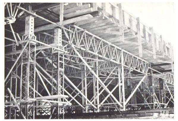
Abb. 3 Ansicht eines Lehrgerüstfeldes mit Mittelfundament.
