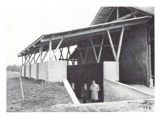
Abb. 4 Überdeckter Flachsilo an der Stirnseite einer Scheune Baukosten: Im Mittel inkl. Aushub, Sickersaftableitung und Schöpfschacht, ca. Fr. 55.— je m³ Siloca. Fr. 40 je m³ Siloraum
