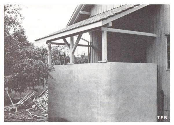
Abb. 7 Halbhochsilo rechteckig mit Formsteinen erstellt Auswurfluken direkt in die Scheune (nicht sichtbar). Baukosten: Im Mittel inkl. Aushub, Sickersaftableitung und Schöpfschacht, ca. Fr. 55.— je m<sup>3</sup> Siloraum ohne Bedachung
