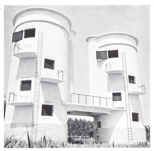
Abb. 9 Siloanlage an der Futterachse plaziert Baukosten der Silos mit mechanischer Presseinrichtung, sichtbaren Futterabwurfschächten und überdecktem Futtergang im Mittel: ca. Fr. 105.— je m<sup>3</sup> Siloraum
