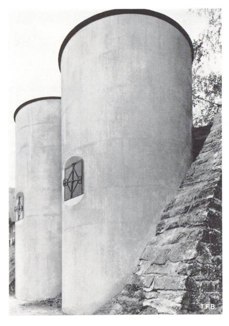
Abb. 8 Hochsiloanlage an einer Scheuneneinfahrt Baukosten der Betonsilos von 3,00 bis 3,50 m  $\phi$  und 6,00 bis 10,00 m Höhe betragen im Mittel: ca. Fr. 45.— je m³ Siloraum
