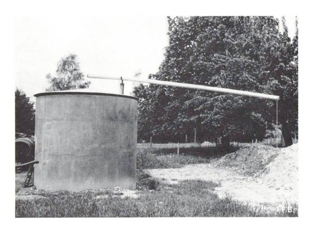
Abb. 6 Halbhochsilo rund mit Tauchdeckel als Bedachung Baukosten: Im Mittel inkl. Aushub, Sickersaftableitung und Schöpfsacht, ca. Fr. 55.— je m³ Siloraum ohne Tauchdeckel und ca. Fr. 75.— je m³ Siloraum mit Tauchdeckel
