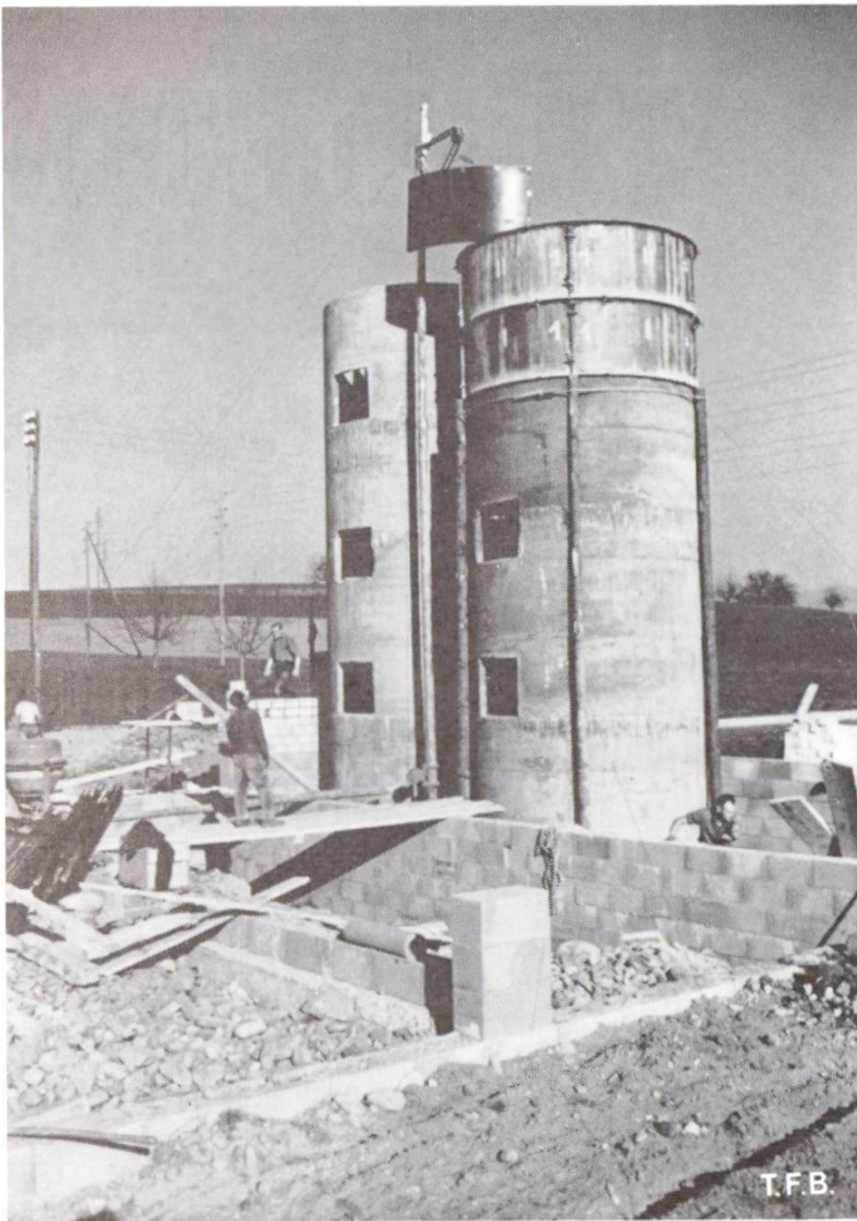
Abb. 2 Betonieren von Hochsilos mit der Steigschalung
