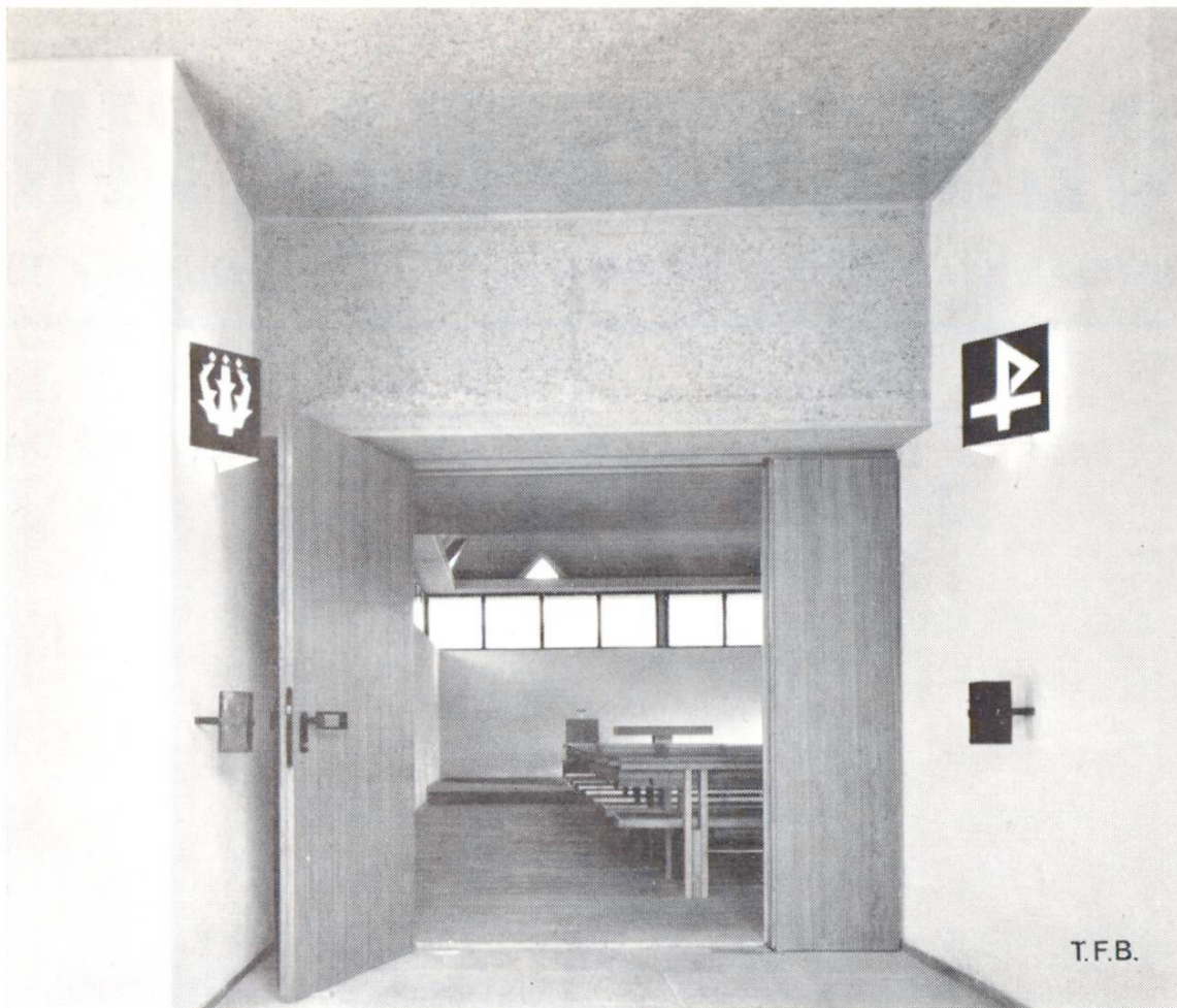
Abb. 1 Eingangspartie mit Decke und Unterzug in gestocktem Sichtbeton
