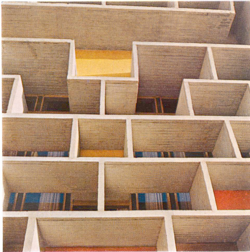
Abb. 2 Detail des «brise soleil» des Gerichtsgebäudes; deutlich sieht man das Spiel der rohen Holzschalung
