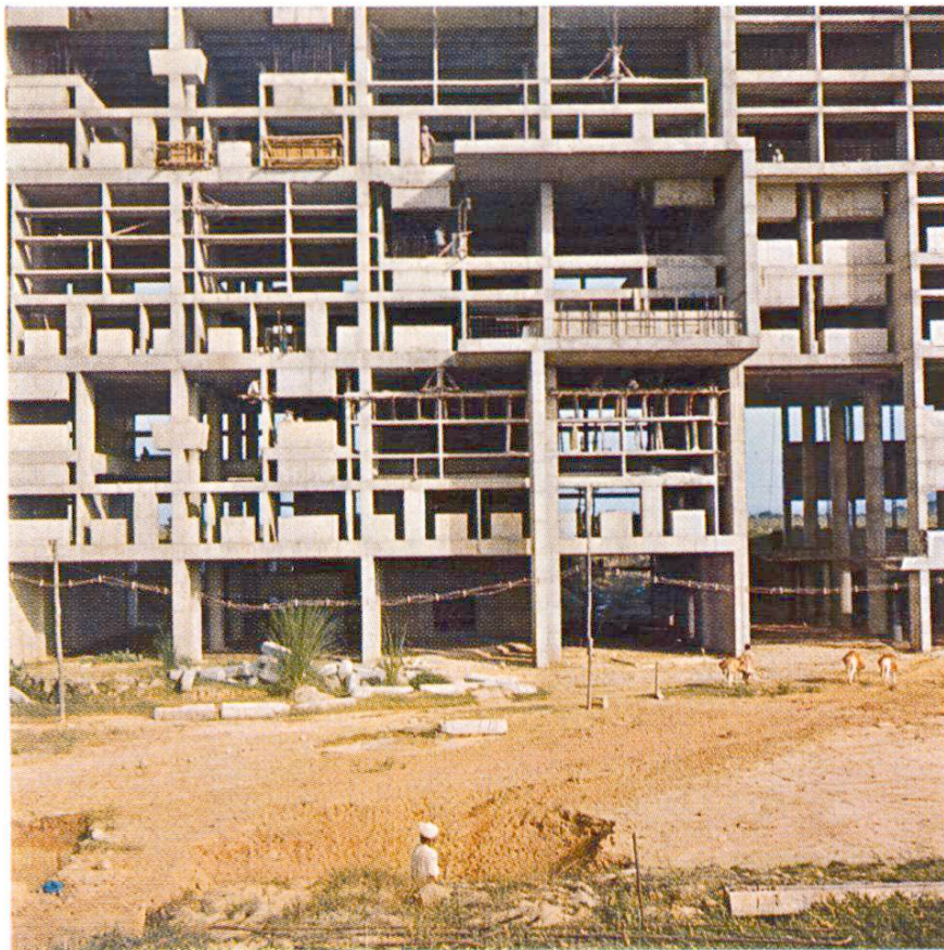
Abb. 5 Ausschnitte aus der Ostfassade des Sekretariatsgebäudes; harmonische Proportionierung und geschickte Anwendung der Schalung lassen Beton zu einem edlen Material werden
