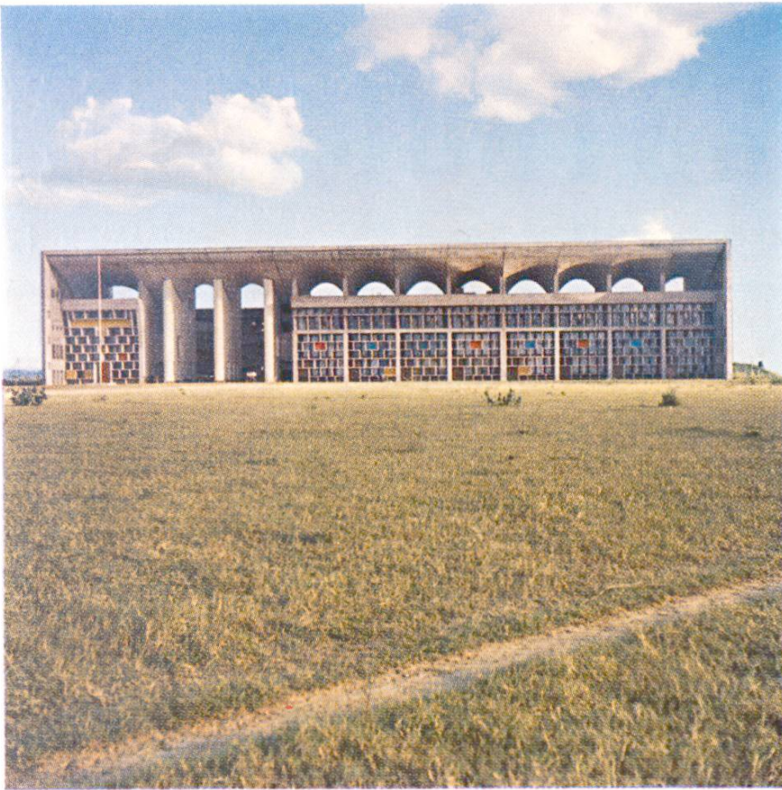
Abb. 1 Das Gerichtsgebäude; das parasolartige Dach schützt vor Sonne und Regen
