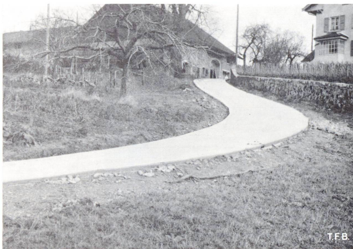
Abb. 8 Beton-Güterweg als Zufahrt zum Bauernhof. Auch Kurven im Gefälle lassen sich ohne besondere Schwierigkeiten ausführen
