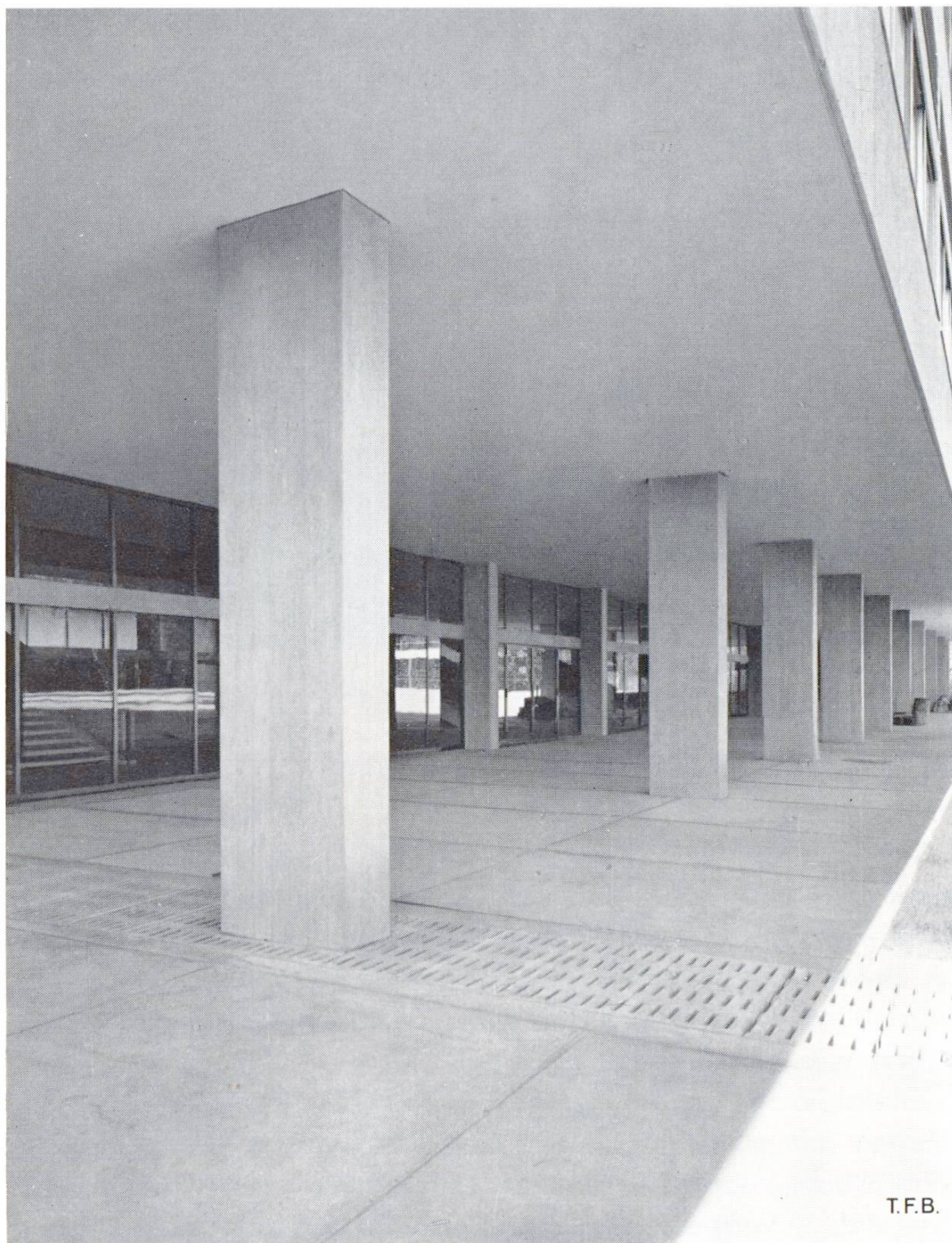
Abb. 6 Säulen in Sichtbeton
