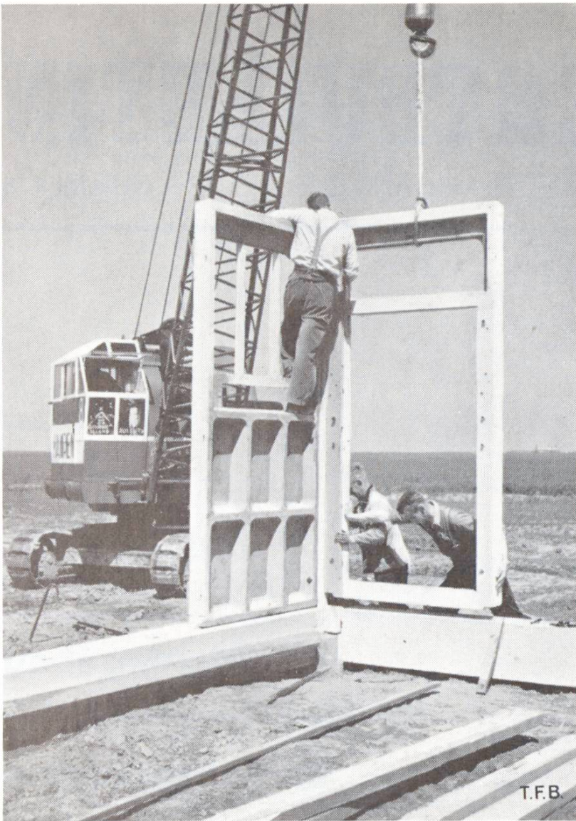
Abb. 1 Bau von landwirtschaftlichen Gebäuden im neugewonnenen Kulturland der Zuidersee (Holland). Zur Montage der schweren Wandelemente dient ein leicht beweglicher Kran
