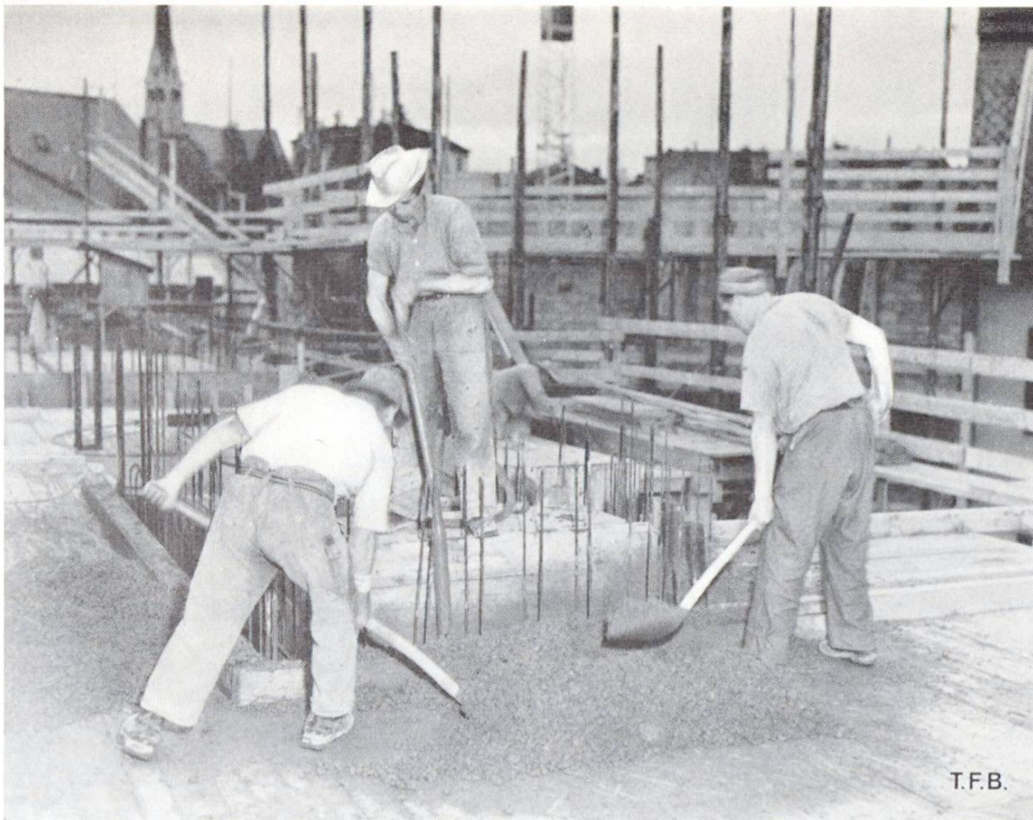
Abb. 4 Bei hohen Fallstrecken oder starker Armierung soll der Beton in kleinen Portionen und vielen einzelnen Schichtfolgen eingebracht werden
