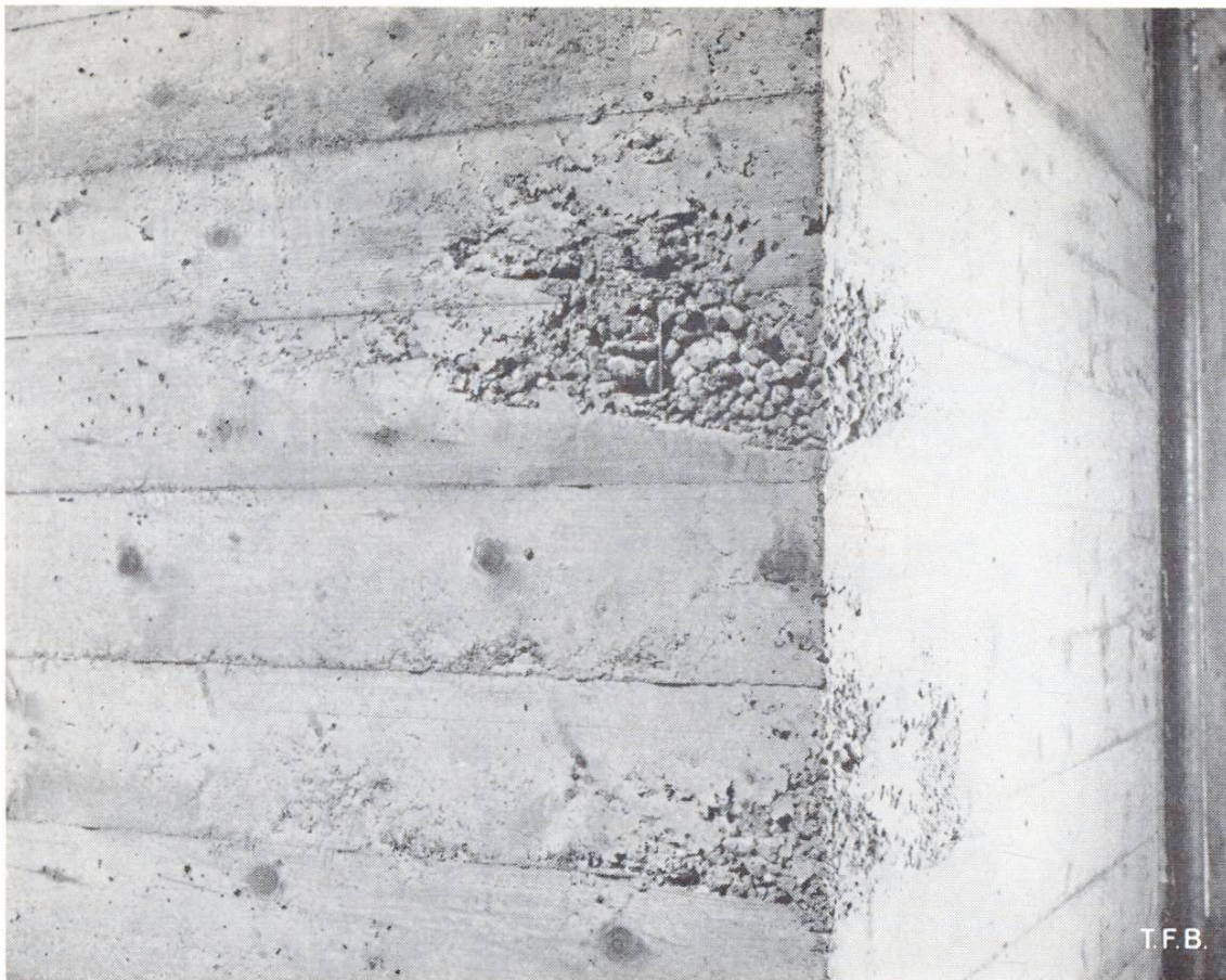
Abb. 3 Kiesnester in der Mauerecke. An diesen Stellen muss das Einbringen mit noch erhöhter Sorgfalt geschehen
