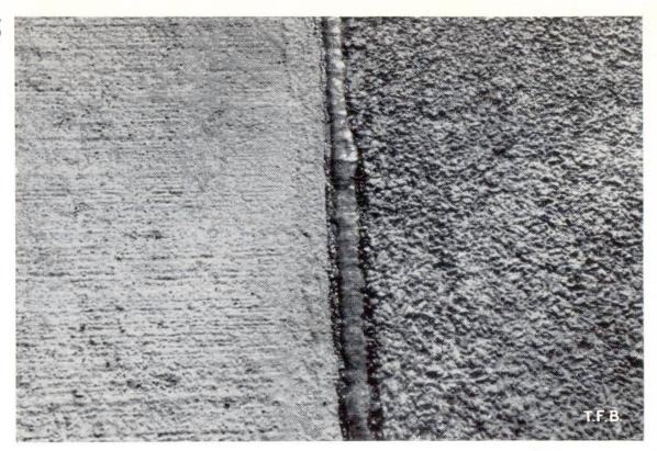
Abb. 4 Oberflächenstruktur eines gewöhnlichen Beton-Strassenbelages und eines Rauhbelages für spezielle Strassenverhältnisse. Der Rauhbelag besteht z.B. aus einer 3 cm dicken Schicht einer Betonmischung P 450 mit ausgesuchtem gebrochenem Steinmaterial 3/8 mm ohne Sand
