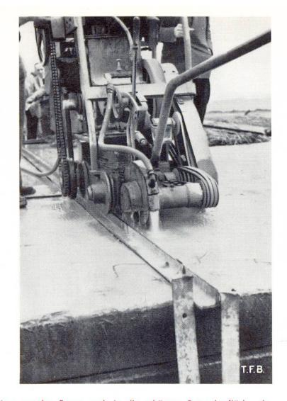
Abb. 10 Mit speziellen Maschinen werden Fugen auch in die erhärtete Betonoberfläche eingefräst. Der 20—40 mm tiefe Spalt bewirkt, dass durch das Schwinden des jungen Betons verursachte Risse nur an diesen vorbereiteten Stellen entstehen
