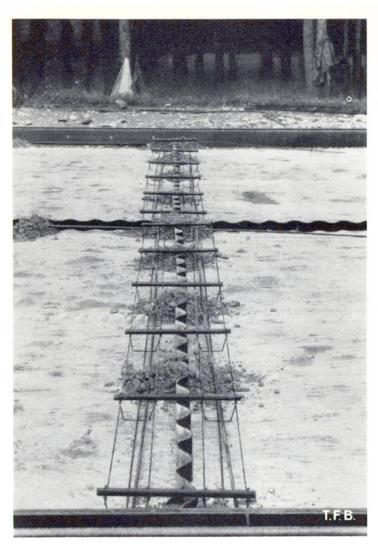
Abb. 5 Moderne Fugenausbildung, Mittelfuge und Kontraktionsfuge mit Welleternit-Einlage. Zwischen dem geraden Fugeneinschnitt im Oberbeton und der Welleternit-Einlage entsteht eine geführte Rissfläche, welche die gewünschte Verzahnung herbeiführt. Als zusätzliches Mittel der gegenseitigen Fixierung und Kraftübertragung dient die Verdübelung durch Rundstahl (bis vor kurzem wurde hierzu lediglich normales Beton-Rundeisen verwendet)
