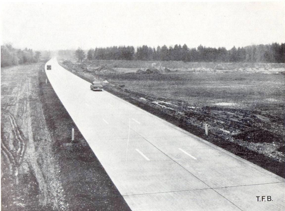
Abb. 11 Die neue Betonstrasse Bern — Biel (Studen — Lyss). Die Querfugen sind einvibriert, die Längsfugen nachträglich in den erhärteten Beton eingefräst und absolut unspürbar. Zusammen mit der vollständig ebenen aber doch rauhen und griffigen Oberfläche, welche durch zusätzlichen Einsatz des neuen Längsfertigers entsteht, ist der Fahrkomfort musterhaft
