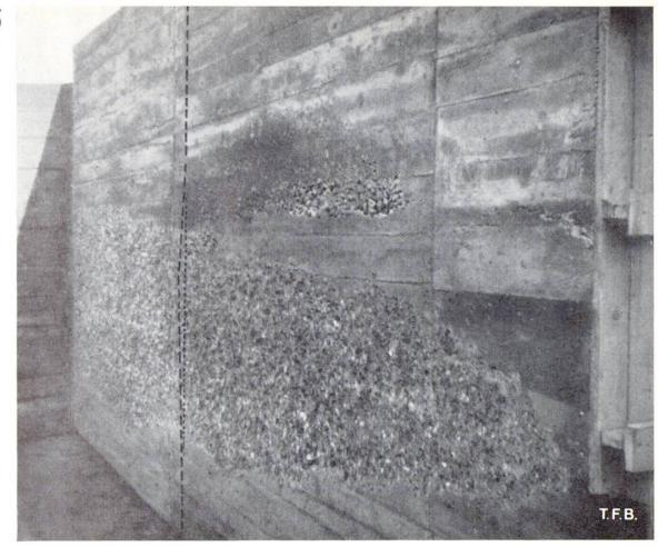
Abb. 3 Beim Betonieren dieser 16 cm starken Wand hat wegen zu hoher Schüttgeschwindigkeit der Schalungsdruck dermassen zugenommen, dass einige Schalungsdrähte rissen. Es war nur einem Zufall zu verdanken, dass nicht das ganze Werk einstürzte. Immerhin entstand eine Ausbuchtung der Wandfläche, die abgepickelt werden musste
