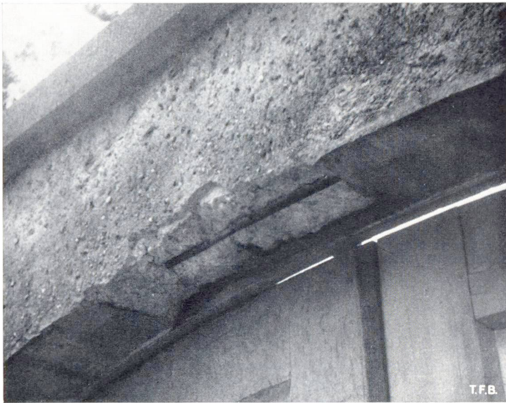
Abb. 3 Die Unterseite dieses betonierten Torbogens wurde mit einem sehr fetten Cementmörtel in beträchtlicher Dicke verputzt. Das unterschiedliche Verhalten zwischen dieser allzuharten Schicht und ihrer Unterlagen (relativ magerer Beton, Verputz mit HK-Mörtel) musste zu ausgedehnten Rissebildungen und schliesslich zur Zerstörung führen
