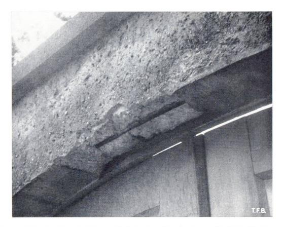
Abb. 3 Die Unterseite dieses betonierten Torbogens wurde mit einem sehr fetten Cementmörtel in beträchtlicher Dicke verputzt. Das unterschiedliche Verhalten zwischen dieser allzuharten Schicht und ihrer Unterlagen (relativ magerer Beton, Verputz mit HK-Mörtel) musste zu ausgedehnten Rissebildungen und schliesslich zur Zerstörung führen
