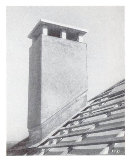
Abb. 4 Mit hydraulischem Kalkmörtel verputztes Kamin. Feuchtigkeits- und Temperatureinwirkungen sind bei einem solchen Bauteil, sowohl von innen als auch von aussen, besonders ausgeprägt. Dies, wie auch der Anschluss an die Dachbedeckung, verlangen eine aussergewöhnliche Fähigkeit der Verputzschichten zur räumlichen Angleichung
