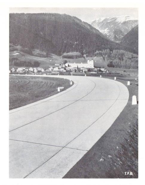
Abb. 2 Grosse Kurve bei Pt. 1126. Blick gegen Disentis. Die Strasse ist hier durch seitliche Streifen verbreitert. Die beiden mittleren Fahrbahnstreifen sind durchwegs je 3 Meter breit
