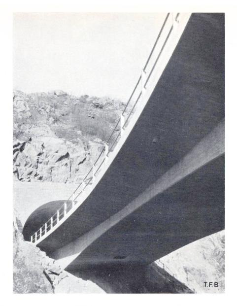
Abb. 5 Bei Pt. 1237, am oberen Ende der Schlucht, setzt die neue Strasse, aus einer Felsrippe hervortretend, direkt über den Medelser Rhein. Vorgespannte Betonbrücke mit gebogener Fahrbahn
