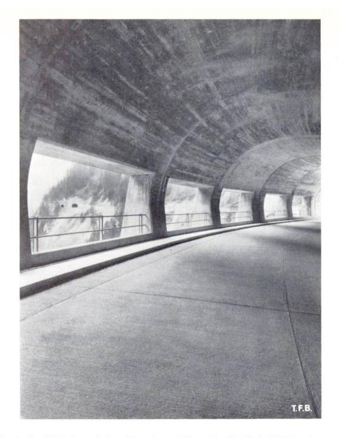
Abb. 4 Schutzgalerie in der Schlucht zwischen Disentis und Curaglia. Die Einheitlichkeit des Materials des Strassenbelages und der Kunstbauten sowie die natürliche helle Farbe verleihen das Gefühl erhöhter Sicherheit. Die Oeffnungen lassen den Blick frei in eine der zahlreichen steilen Runsen und im Hintergrund erkennt man am alten und neuen Tunneleingang das Ausmass der Strassenverbreiterung
