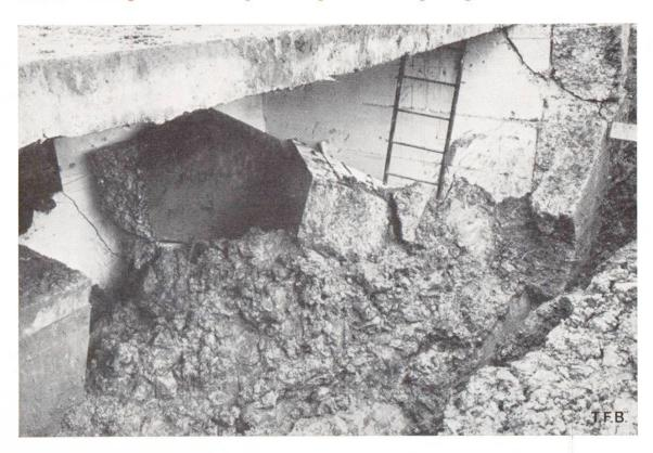
Abb. 3 Sprengversuche an einem Schutzraum aus Beton. Als Kasten kreuzweise armiert, Eisen  $\varnothing$  10 mm, Abstände aussen 30 cm, innen 15 cm. Versuchsanordnung. 1. Spengung in 4 m Abstand, 2. in 3 m Abstand
