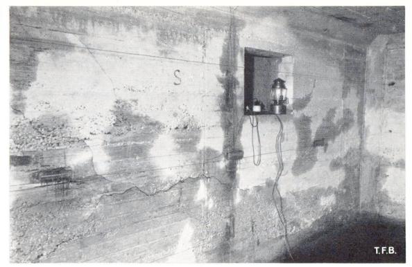
Abb. 3a Zustand der Wand innen nach der ersten Sprengung
