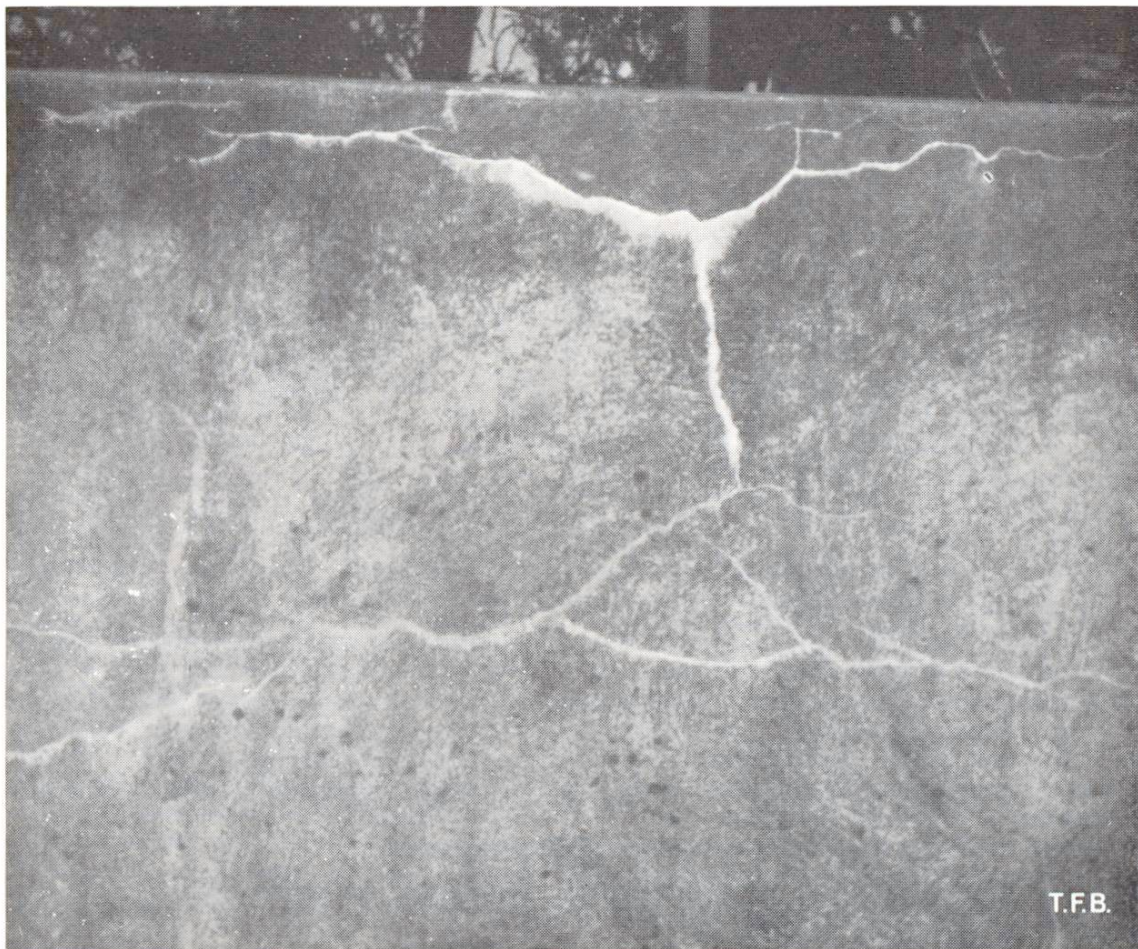
Abb. 2 Diese Risse in einer Stützmauer sind vollständig zugewachsen. Im oberen Abschnitt, wo offenbar ein stärkerer Wasserdurchsatz stattfand, kam es stellenweise auch zu äusseren Kalk-Ausscheidungen
