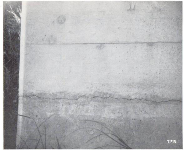
Abb. 3 Starker Setzungsriss eines Pfeilers entlang der Arbeitsfuge. Hier zeigen sich Ansätze einer allerdings sehr langsam fortschreitenden Selbstheilung infolge der aufsteigenden Erdfeuchtigkeit
