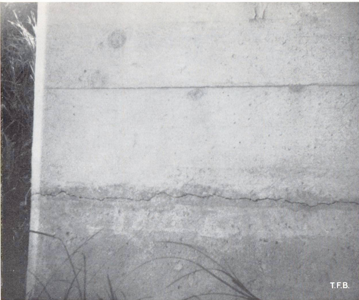
Abb. 3 Starker Setzungsrisse eines Pfeilers entlang der Arbeitsfuge. Hier zeigen sich Ansätze einer allerdings sehr langsam fortschreitenden Selbstheilung infolge der aufsteigenden Erdfeuchtigkeit
