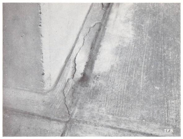
Abb. 5a und b Aussprengungen am Betonbelag entlang einer Gebäudemauer entsprechend Abb. 2b. Die Fuge sollte genau über der Fundamentkante liegen. An dieser Stelle stösst aber der wandseitige Belag etwa 5 mm über die senkrechte Trennfläche zwischen Fundament und Betonbelag hinaus und eine geringe Frosthebung genügte, um den Schaden herbeizuführen. Die Aufnahme rechts zeigt die Situation deutlich, insbesondere erkennt man die Spur der Dachpappeneinlage am ausgebrochenen Stück
