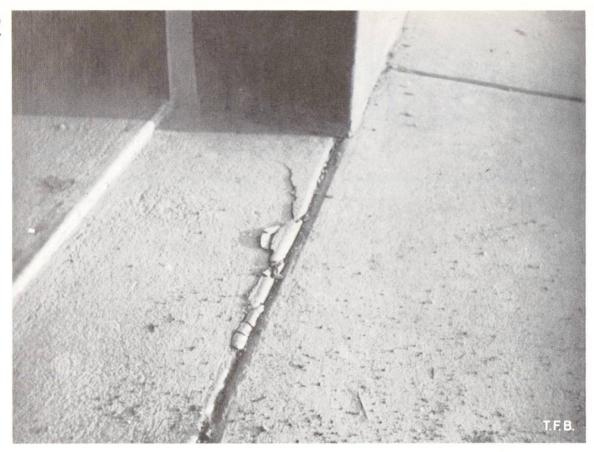
Abb. 1 Zerstörung der Fugenkante infolge Verunreinigung der Fuge bei vorausgegangener Schwächung durch starkes Besprengen mit Wasser bei der Bearbeitung
