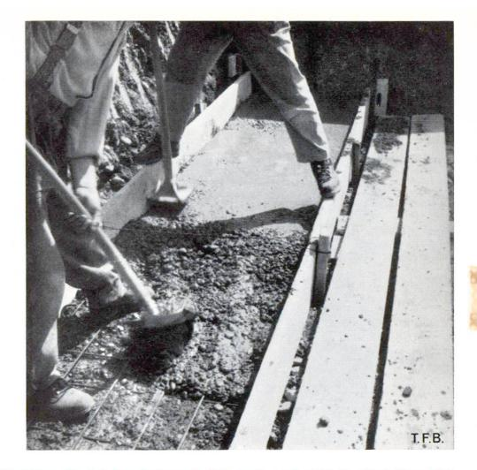
Abb. 9 Ein Fehler, der bei Bauarbeiten auf dem Lande noch vielfach angetroffen wird: Zu flüssiger Beton
