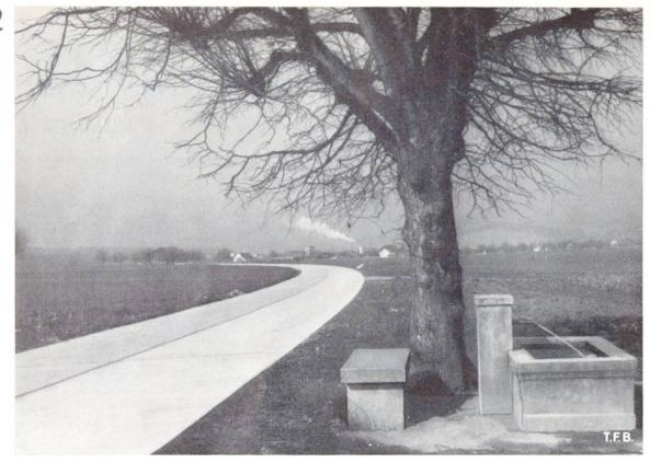
Abb. 1 Betonstrassen-Versuchsstrecke Möriken - Brunegg, Kt. Aargau
