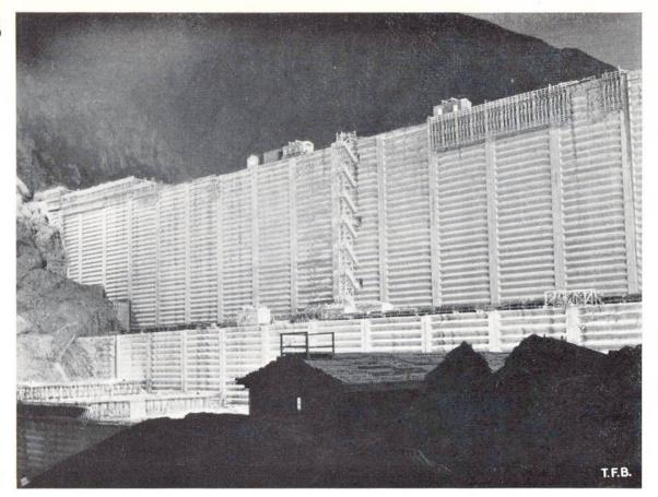
Abb. 6 Staumauer Grande Dixence, Bauzustand August 1957, zirka 2,5 Millionen m<sup>3</sup> Beton
