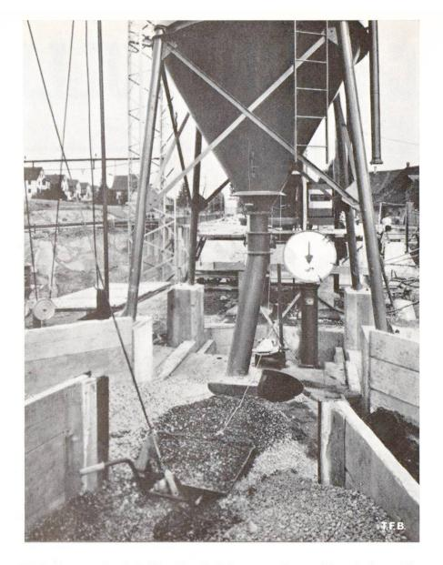
Abb. 1 Neue Beton-Mischanlage mit drei Zuschlagsfraktionen und gewichtsmässiger Zumessung
