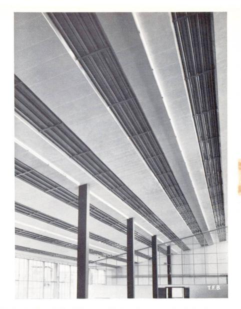
Abb. 8 Innenansicht der fertigen Halle. Die glatte Deckenwirkung wurde durch das Anbringen von Akustikplatten erzielt
