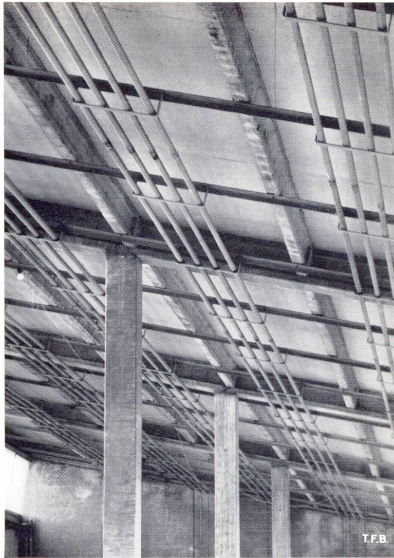
Abb. 7 Rohbauansicht der Binder- und Pfettenkonstruktion mit der aufgehängten Deckenstrahlungsheizung (Aufnahme: Jürg Ganz)
