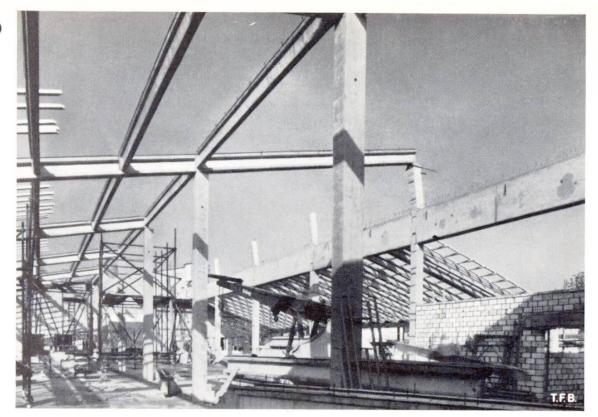
Abb. 5 Montagebild. Links grosses Pultdach, rechts kleines Pultdach mit der fertig erstellten Holzkonstruktion
