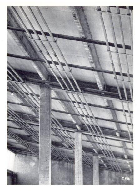
Abb. 7 Rohbauansicht der Binder- und Pfettenkonstruktion mit der aufgehängten Deckenstrahlungsheizung (Aufnahme: Jürg Ganz)
