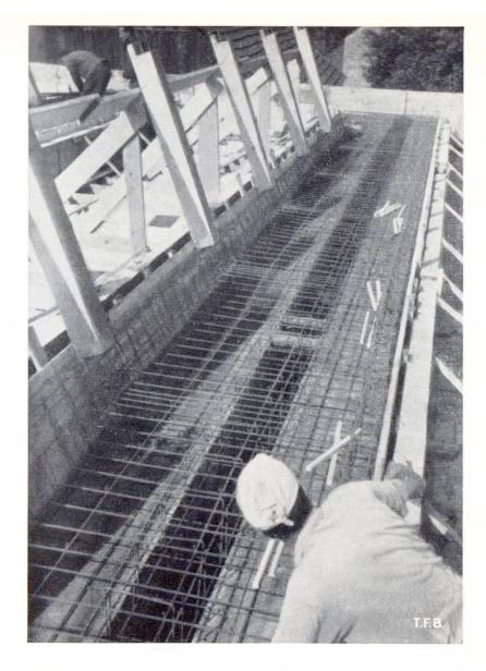
Abb. 4 Armierung eines Rinnenträgers. Die Shedstützen werden durch ein Brettergerüst in der richtigen Lage festgehalten
