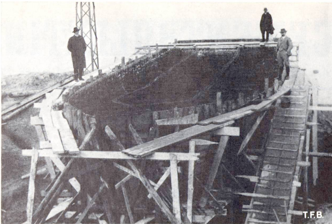
Abb. 1 Aufnahme vom Bau der «Seeland». Man erkennt die Armierung des Decks mit Verstärkungen am Rande und den beiden parallel verlaufenden, vorne zusammenkommenden Längsrippen
