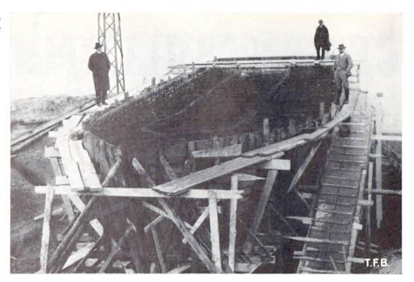
Abb. 1 Aufnahme vom Bau der «Seeland». Man erkennt die Armierung des Decks mit Verstärkungen am Rande und den beiden paral!el verlaufenden, vorne zusammenkommenden Längsrippen
