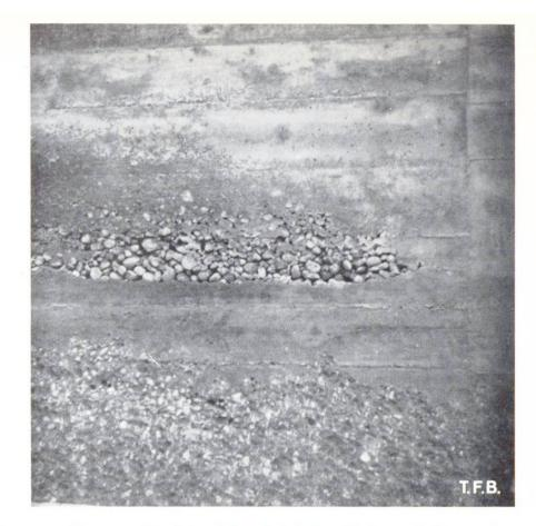
Abb. 4 Dieses Kiesnest wurde verursacht, indem bei relativ hoher Schalung direkt aus dem Transportkübel eingebracht wurde. Es hätte sich vermeiden lassen, wenn der Beton zunächst in eine Wanne gefüllt und dann eingeschaufelt worden wäre
