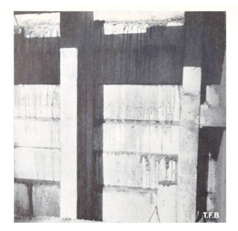
Abb. 1 Zu flüssiger Beton und undichte Schalung haben Verluste an Cementleim zur Folge
