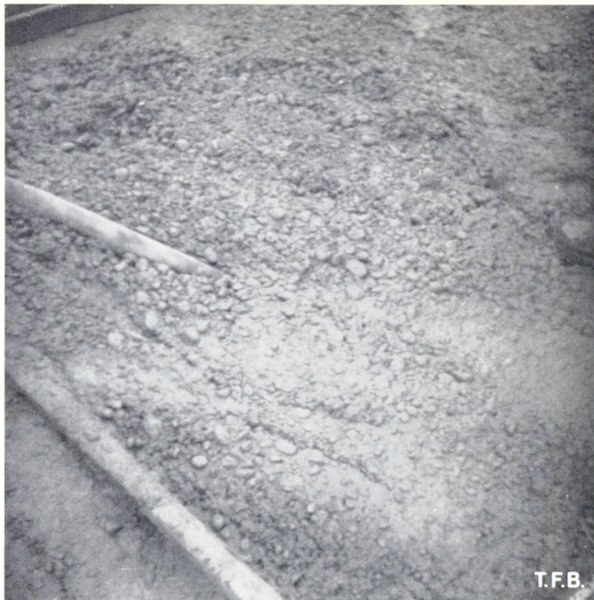
Abb. 5 Durch richtiges Vibrieren verflüssigt sich selbst ein steifplastischer Beton. Vibration schliesst die Verwendung von flüssigem Beton aus!
