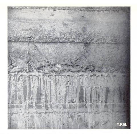
Abb. 3 An den Arbeitsfugen besteht die Gefahr des Bindemittelverlustes, wenn, wie in diesem Beispiel, die neue Schalung am alten Beton nicht gut anschliesst. Da gerade die Arbeitsfugen einen heiklen Punkt des Betonbaues darstellen, müssen kleine Fehler dieser Art vermieden werden
