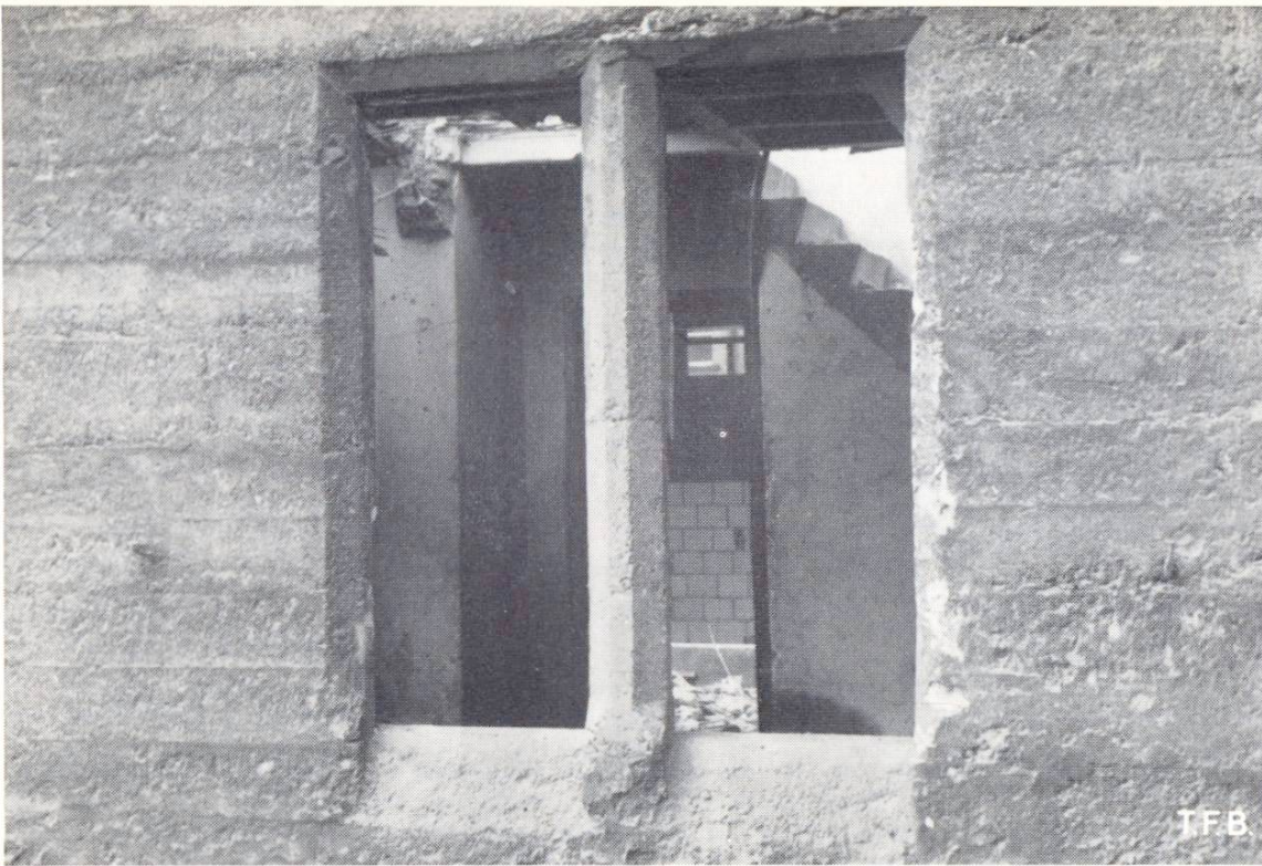
Abb. 2 Fassade mit Doppelfenster in Sichtbeton. Im Hintergrund die in Beton vorgefabrizierten Treppenstufen
