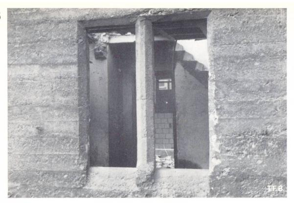
Abb. 2 Fassade mit Doppelfenster in Sichtbeton. Im Hintergrund die in Beton vorfabrizierten Treppenstufen
