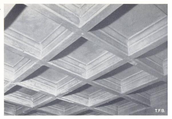
Abb. 3 Decke bestehend aus aneinandergereihten Gipskassetten mit ausbetonierten, armierten Fugen
