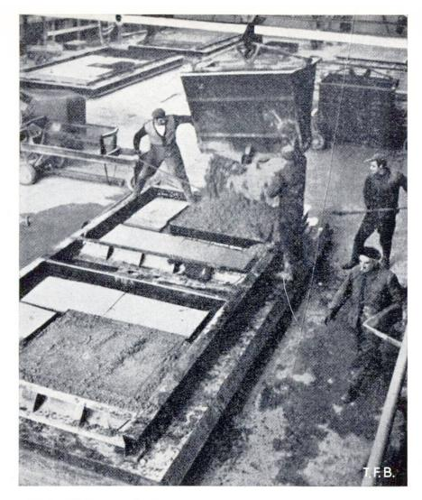
Abb. 1 Einbringen des Betons in eine liegende Form.
