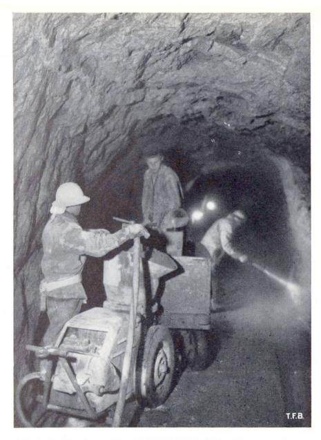
Abb. 1 Betonspritzmaschine im Einsatz beim Stollenbau
