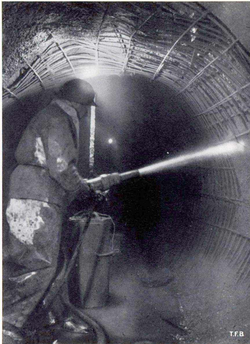
Abb. 3 Mehrschichtige armierte Stollenauskleidung bei sehr brüchigem Fels
