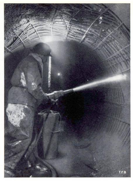
Abb. 3 Mehrschichtige armierte Stollenauskleidung bei sehr brüchigem Fels
