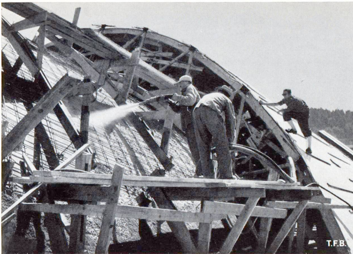
Abb. 5 Die Schalen wurden im Spritzverfahren ohne Konterschaltung betonierte (P 325, Kiessand 0/20 mm). Sie sind vom Scheitel bis zum Auflager zunehmend 7 bis 12 cm dick
