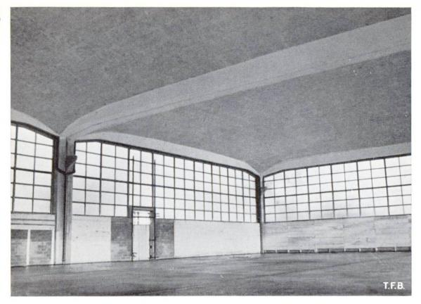
Abb. 2 Blick ins Innere der mit Buckelschalen überdeckten Fabrikhalle. Als Schalung wurden 50 mm starke Holzfaserplatten über die Lehren gelegt, die nun die Funktion der Dachisolation übernehmen. (Glasfabrik Bützberg, Ingenieur: Weder & Prim, St. Gallen/Burgdorf)
