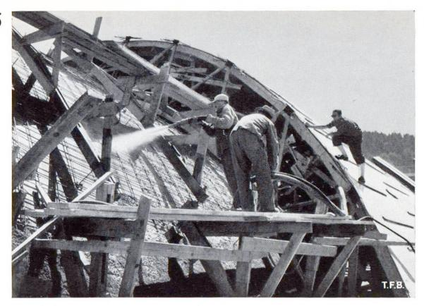
Abb. 5 Die Schalen wurden im Spritzverfahren ohne Konterschalung betoniert (P 325, Kiessand 0/20 mm). Sie sind vom Scheitel bis zum Auflager zunehmend 7 bis 12 cm dick
