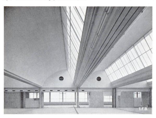
8 Die Vorspannung verbessert den Spannungszustand solcher Schalen wesentlich und erlaubt die wirtschaftliche Überdeckung grosser Spannweiten.
