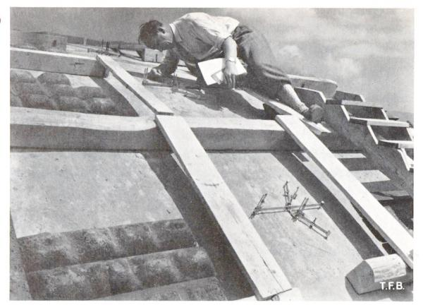
Fig. 5 Belastungsprobe am ausgeführten Bauwerk. Von grossem Interesse war ein Vergleich des Verhaltens des wirklichen Bauwerkes und des Modelles. Durch die EMPA sind umfangreiche Messungen vorgenommen worden. Auf dem Bild sind sternförmig montierte Tensometer sichtbar, die am entsprechenden Schalenteil die Dehnungen messen, welche am Modell durch die Dehnungsmesstreifen ermittelt wurden
