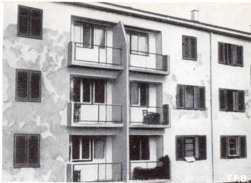
Abb. 3 Ablösung einer Putzschicht infolge schlecht gereinigter Unterlage
