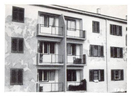
Abb. 3 Ablösung einer Putzschicht infolge schlecht gereinigter Unter-
