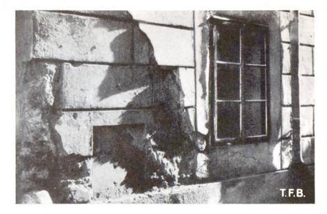
Abb. 5 Ablösung eines Mörtelüberzuges, der an einer zu glatten Fläche und zudem in zu grosser Dicke aufgetragen wurde. Die Dicke einzelner Putzschichten soll 2 cm nicht übersteigen
