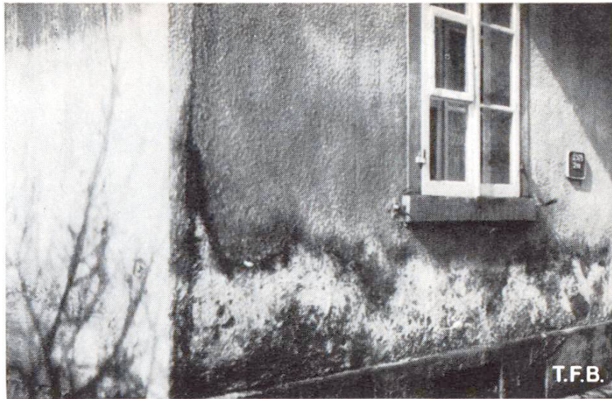
Abb. 4 Verfärbungen und Ausblühungen als Folge fehlender Horizontalisolierung
