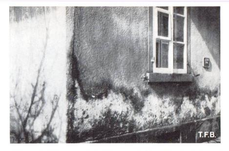
Abb. 4 Verfärbungen und Ausblühungen als Folge fehlender Horizontalisolierung
