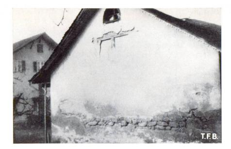
Abb. 2 Putzfläche unten zerstört infolge aufsteigender Bodenfeuchtigkeit, oben Ablösung wegen des verschiedenen Verhaltens von Holzbalken und Mauerwerk (inhomogene Grundfläche)
