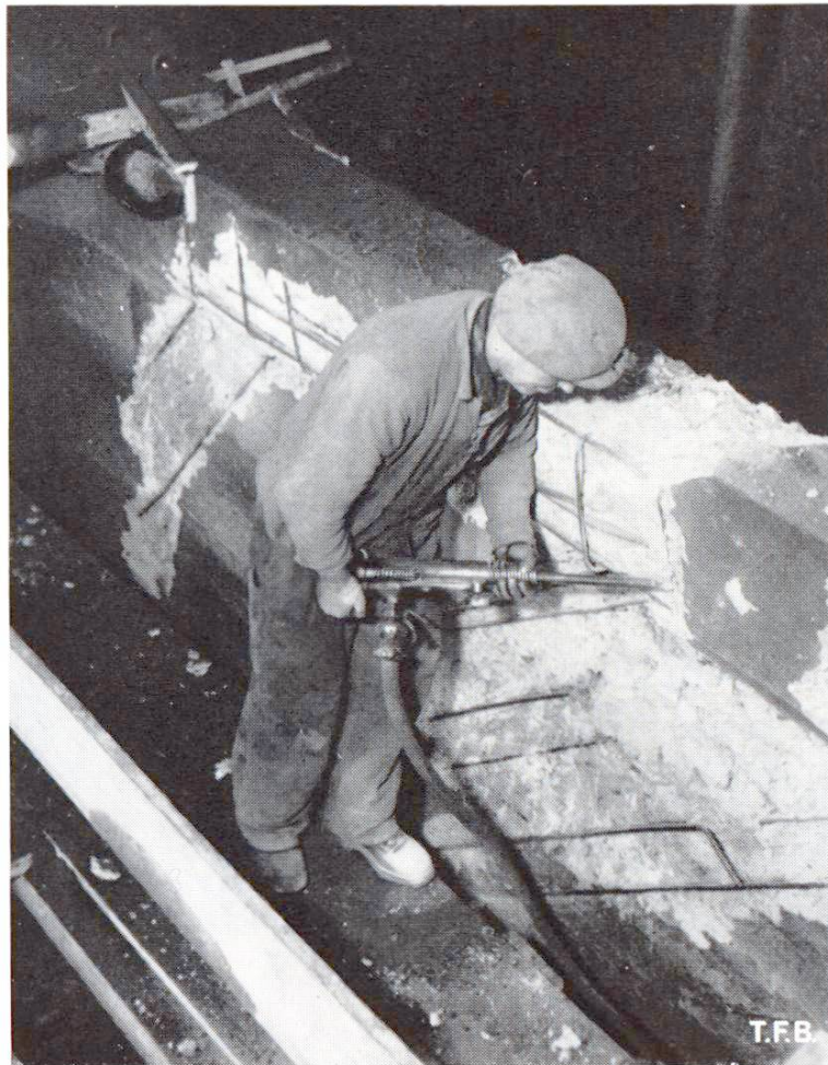
Abb. 3 Entfernung schadhaften Betons. Der Hammer wird zur Schonung der gesunden Teile möglichst schräg geführt
