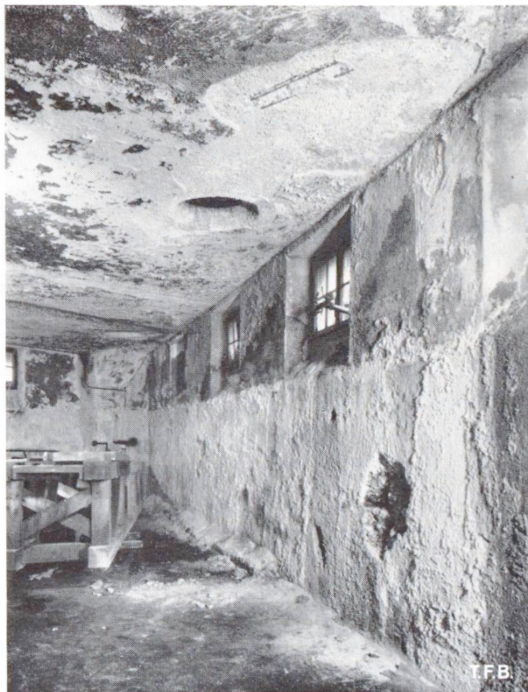
Abb. 1 Starke Oberflächenschäden verursacht durch säure- haltige Atmosphäre
