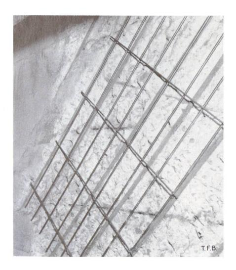
Abb. 5 Leichte Armierung einer grösseren Flächenreparatur
