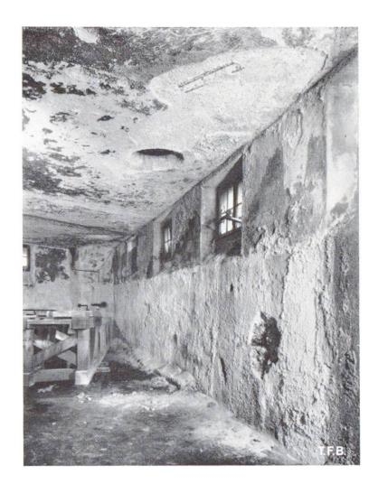
Abb. 1 Starke Oberflächenschäden verursacht durch säurehaltige Atmosphäre
