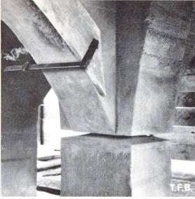
Abb. 6 Gelenkköpfe einer Pendelstütze vor und nach der Instandstellung durch Spritzbeton. An der gewölbten Tragrippe ist die einfache Schalung für die Gunitierung der Kante sichtbar
