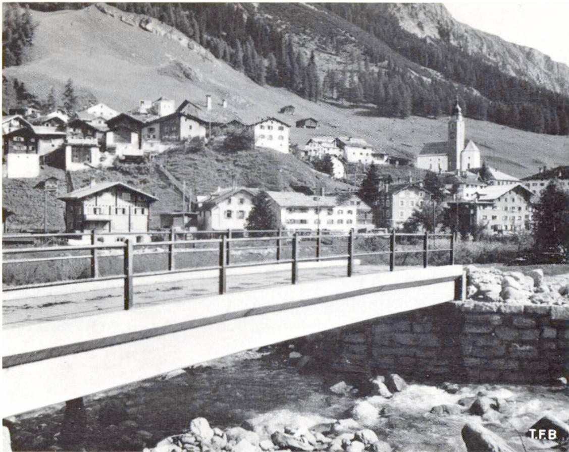
Abb. 3 Kleine Brücke aus vorgefertigten Betonbalken. Spannweite 13 m
