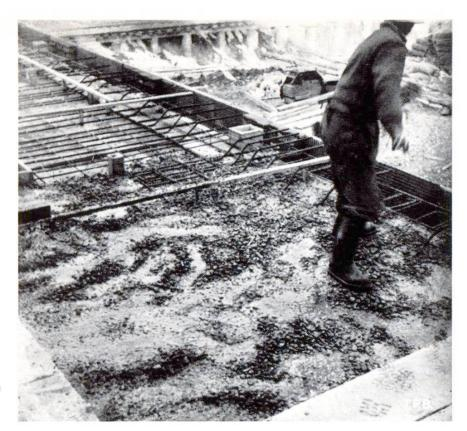
Abb. 5 Starke Entmischung von flüssigem Beton beim Verteilen mit der Schaufel
