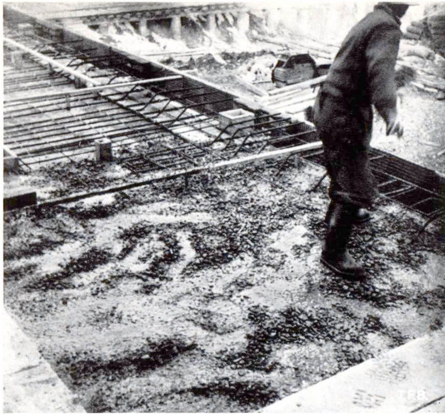
Abb. 5 Starke Entmischung von flüssigem Beton beim Verteilen mit der Schaufel
