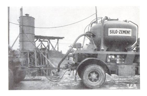
Abb. 3 Beschickung eines Baustellensilos durch Silo-Lastzug von  $2 \times 5,5$  t. Am Motor-fahrzeug sind Instrumente und Verteilerbatterie der Pressluftanlage sichtbar
