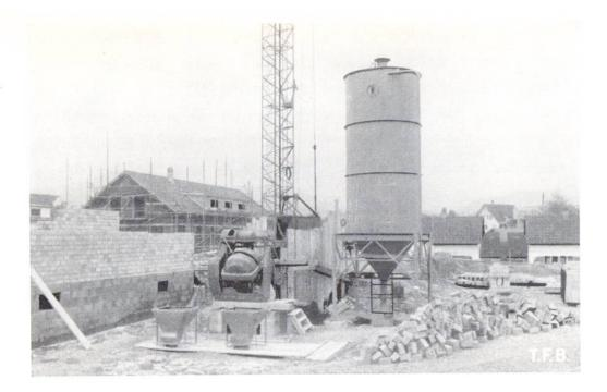
Abb. 4 Cementsilo auf einer kleineren Baustelle
