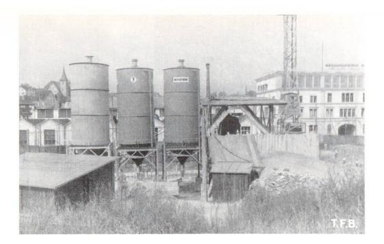
Abb. 6 Cementsilo-Batterie auf einer Grossbaustelle
