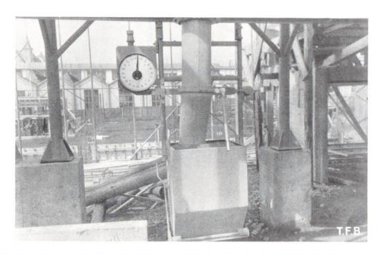
Abb. 7 Cementwaage mit einer Kapazität von 200 kg. Sie dient zugleich als Transportbehälter Silo-Betonmaschine. Die Skala trägt eine verstellbare Marke zur Kenntlichmachung der abzuwiegenden Menge. An der Schraube über der Wägeuhr kann die Null-Stellung einreguliert werden.
