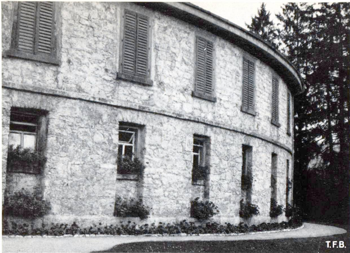
Abb. 5 Bruchsteinmauerwerk aus der Neuzeit. Die Güte des hydraulischen Kalkes ermöglichte hier auf eine eingehende kostspielige Bearbeitung der Bruchsteine zu verzichten
