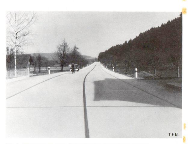
Abb. 9 Betonstrasse von 10,5 m Breite mit systematischer Randmarkierung
