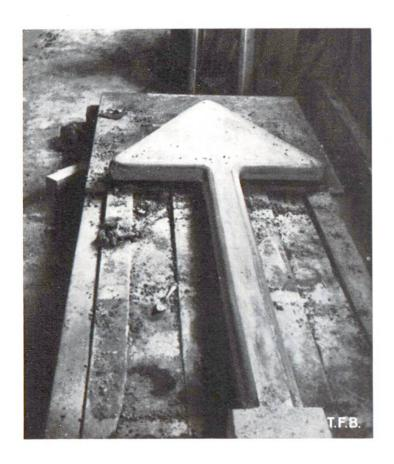
Abb. 5 Im Rohbau fertiger Signalständer
