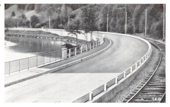
Abb. 8 Betonleitschranke aus leicht montierbaren Betonelementen (schweizerisches System)
