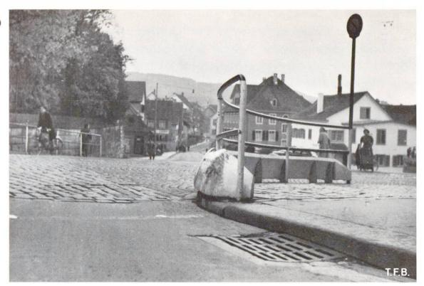
Abb. 6 Sicherheitszaun an stark gefährdeter Trottoirecke. Die Spuren der sehr intensiven Beanspruchung der Leitschranke sind deutlich sichtbar
