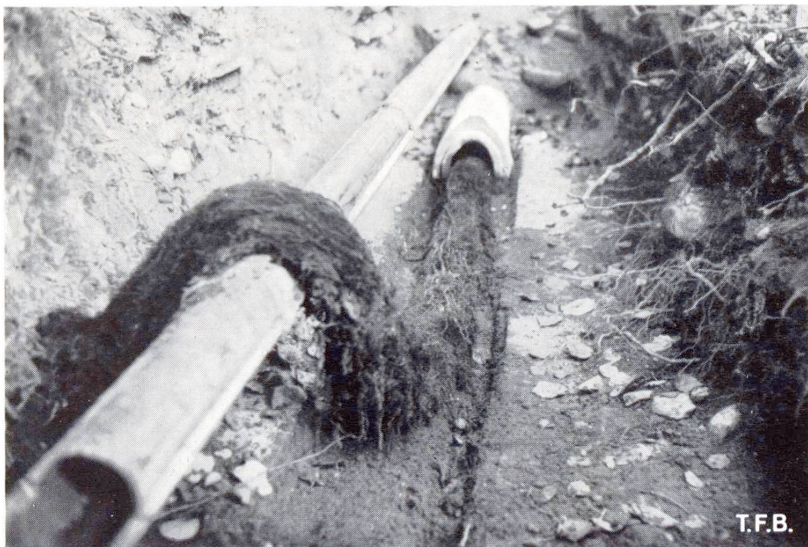
Abb. 2 Wurzelbildung über einem 50 000 Volt Kabel
