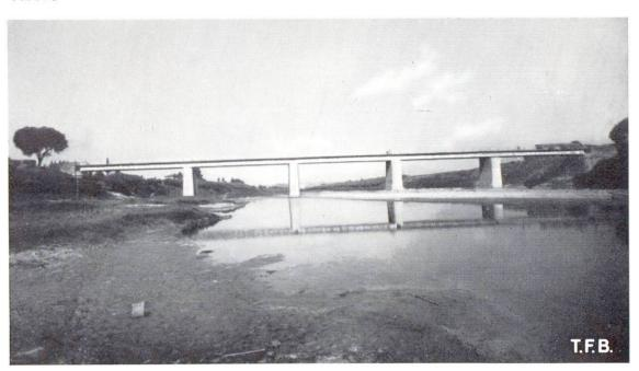
6 hinwegführenden Betonträgers zum Ausdruck. Die horizontale Unterkante ohne Verstärkungen über den Pfeilern wirkt überzeugend und stilrein. Sie ist auch preislich Gewölben vorzuziehen. Der vorgespannte Beton ist jeder Formgebung gewachsen.
