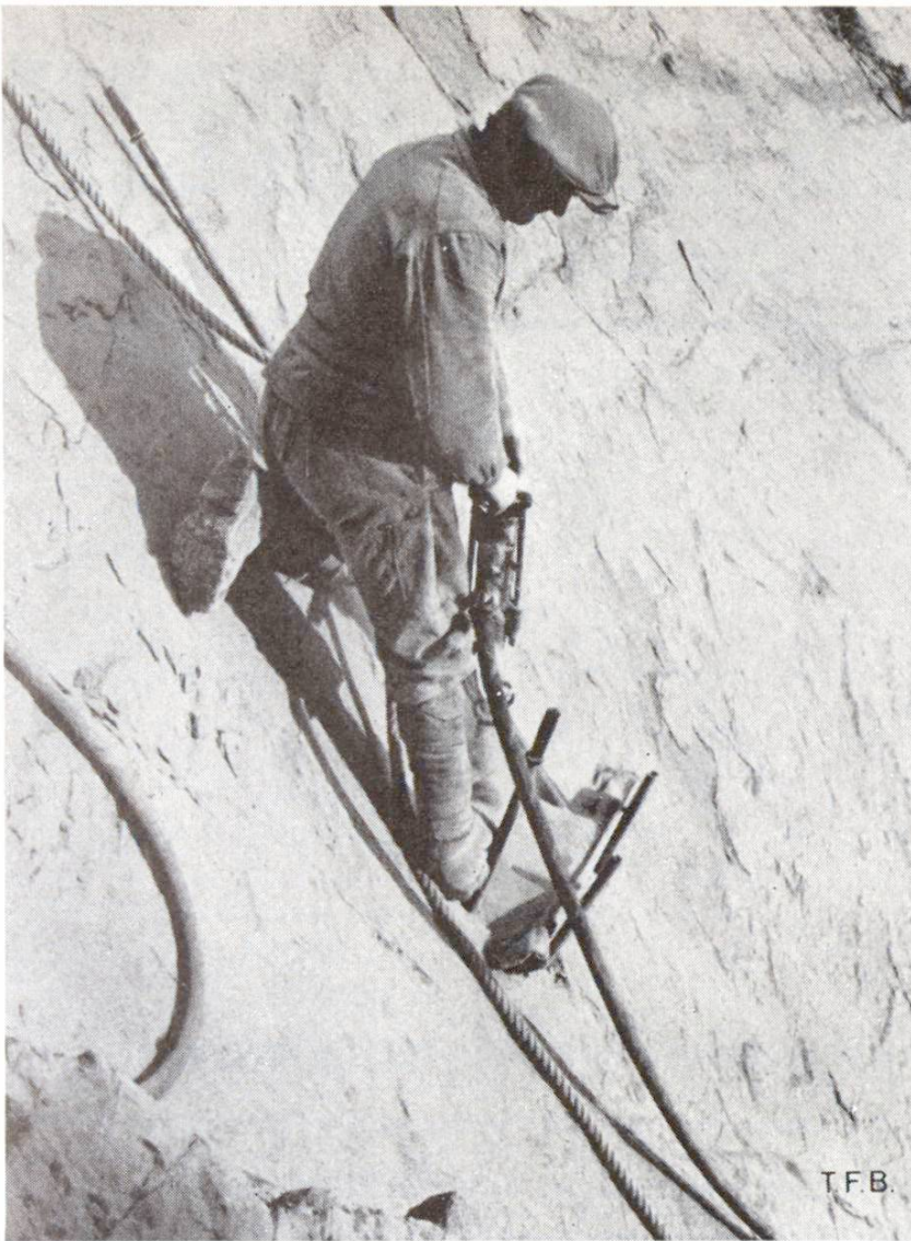
Abb. 1 Mineur beim Bohren an der Wand
