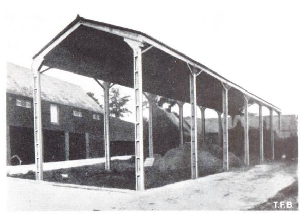
Transport und Montage, ist nur bedingt stichhaltig. Alle Einzelteile können gewichtsmässig so begrenzt werden, dass die üblichen Hebewerkzeuge, Kleinkrane, Aufzüge und Flaschenzüge, die für jede Bauweise sowieso auf den Baustellen zur Verfügung stehen, auch für die Betonelemente ausreichen. Es braucht keine zusätzlichen Geräte. Unter günstigen Verhältnissen können die Tragelemente sogar in Bauplatznähe erstellt werden unter Wegfall der Transportspesen.
