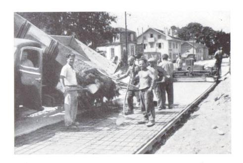
Abb. 8 Einbringen der Oberbetons über den Stahldrahtnetzen
