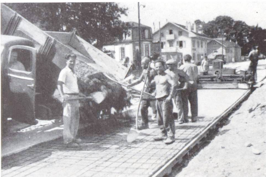
Abb. 8 Einbringen der Oberbetons über den Stahldrahtnetzen
