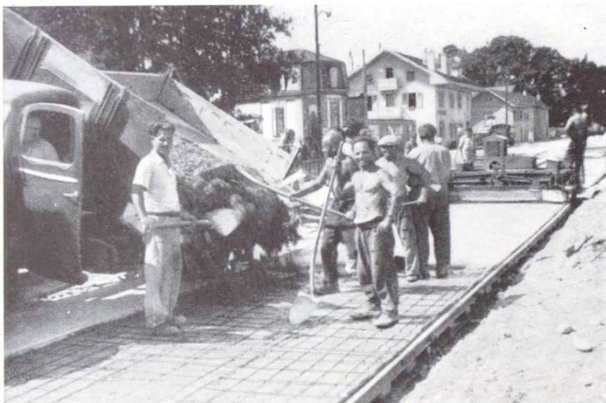
Abb. 8 Einbringen der Oberbetons über den Stahldrahtnetzen
