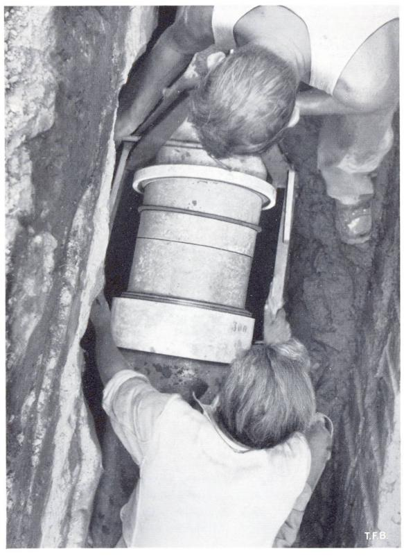
Abb. 7 Bei der Montage einer Leitung von 300 mm Ø, 18 Atm. Prüfdruck
