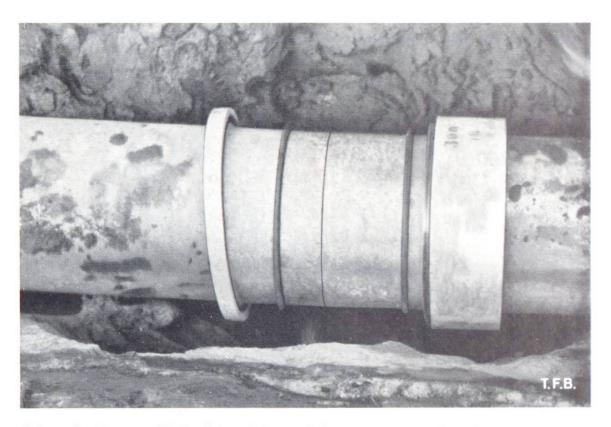
Abb. 6 Position von Muffe, Schraubring und Gummiringen vor dem Aufziehen
