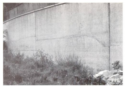
Abb. 6 Betonmauer mit schräg abfallenden Fugen
