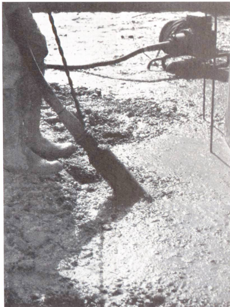
Abb. 5 Verdichten mit Nadelvibrator bis zum Wasseraustritt an der Oberfläche und Nachlassen der Luftblasen
