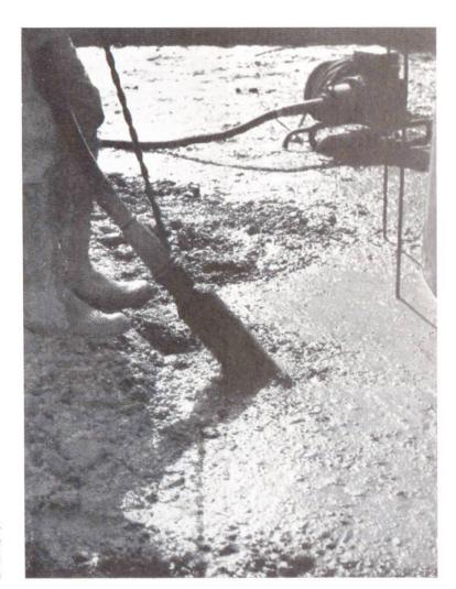
Abb. 5 Verdichten mit Nadelvibrator bis zum Wasseraustritt an der Oberfläche und Nachlassen der Luftblasen
