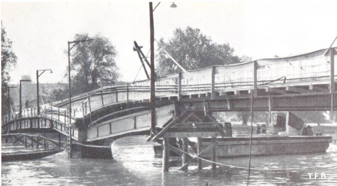
Abb. 14 Aaresteg Aarau, Bauzustand vor dem Einschalen einer Tragrippe, 3 Kabel à 80 Tonnen, über dem Flusspfeiler hochgekrümmt, im Vordergrund Lehrgerüst aus Stahlprofilen, dahinter aus geleimten Holzträgern
