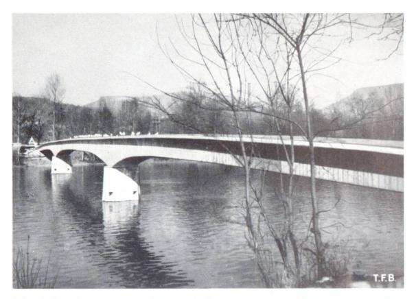
Abb. 15 Fussgängersteg über die Aare in Aarau, 110 m lang, Mittelöffnung 41 m. Bauzustand nach dem Entfernen des Lehrgerüstes
