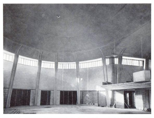
Abb. 17 Vorgespannte Schalenkuppel der Felix und Regula-Kirche Zürich, Raumweite 31 m, Betonstärke 8 cm
