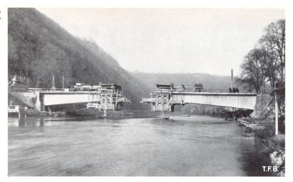
Abb. 10 Lahnbrücke Balduinstein. Freivorbau der Brückenträger mit fahrbaren Betoniergerüsten; DYWIDAG München (Photo Mais, Limburg)
