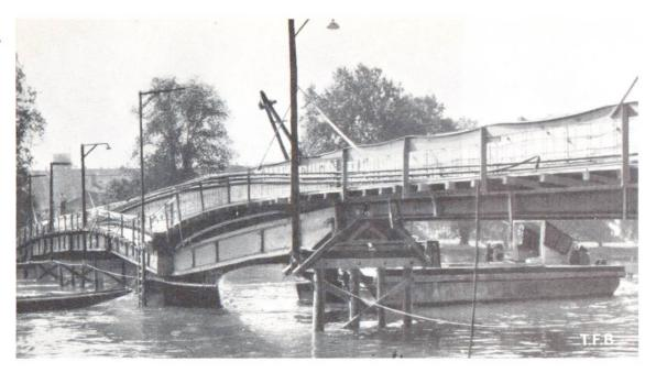
Abb. 14 Aaresteg Aarau, Bauzustand vor dem Einschalen einer Tragrippe, 3 Kabel à 80 Tonnen, über dem Flusspfeiler hochgekrümmt, im Vordergrund Lehrgerüst aus Stahlprofilen, dahinter aus geleimten Holzträgern
