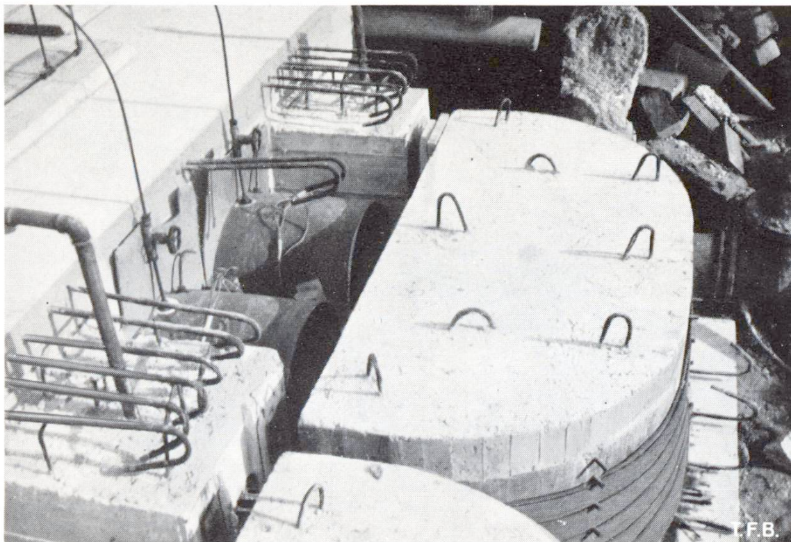
Abb. 3 Halbrunder Betonblock mit zwei hydraulischen Pressen gegen die Stirnfläche der Brückenplatte zum Spannen der endlos gewickelten Litzen nach System Baur-Leonhardt
