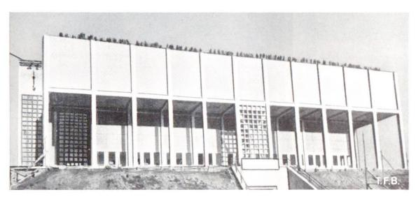
Abb. 6 Hochreservoir der Stadt Orléans 7000 m³. An der oberen Kante sind die noch hervorstehenden Spanndrähte der vertikalen Kabel ersichtlich, System Freyssinet in allen 3 Richtungen des Raumes vorgespannt. Trotz Biegung treten keine Zugsspannungen im Beton auf
