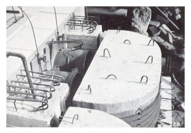
Abb. 3 Halbrunder Betonblock mit zwei hydraulischen Pressen gegen die Stirnfläche der Brückenplatte zum Spannen der endlos gewickelten Litzen nach System Baur-Leonhardt
