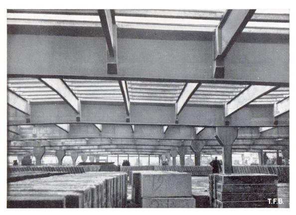
Abb. 8 Baumwollfabrik Gand (Belgien), Innenansicht mit Bindern, Pfetten und Sparren aus vorgespanntem Beton, System Magnel. Im Gegensatz zu Eisenbeton und wie bei Stahlprofilen wirkt hier der Untergurt statisch mit
