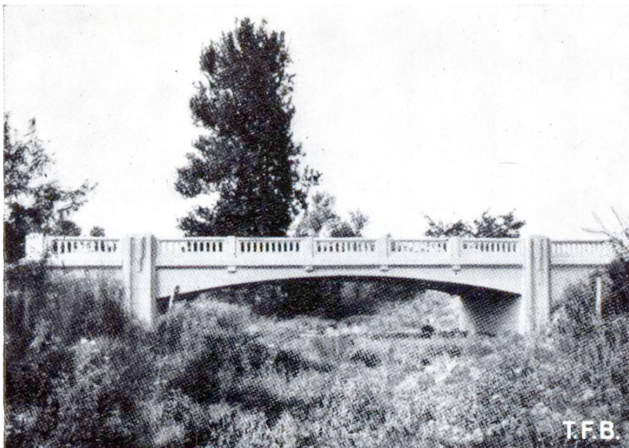
Abb. 8 Bach- brücke in Ame- rika. Beachtens- wert ist die gute architektonische Wirkung
