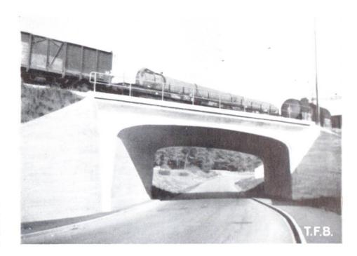
Abb. 6 Interessante schiefe Bahnüberführung in Rahmenkonstruktion
